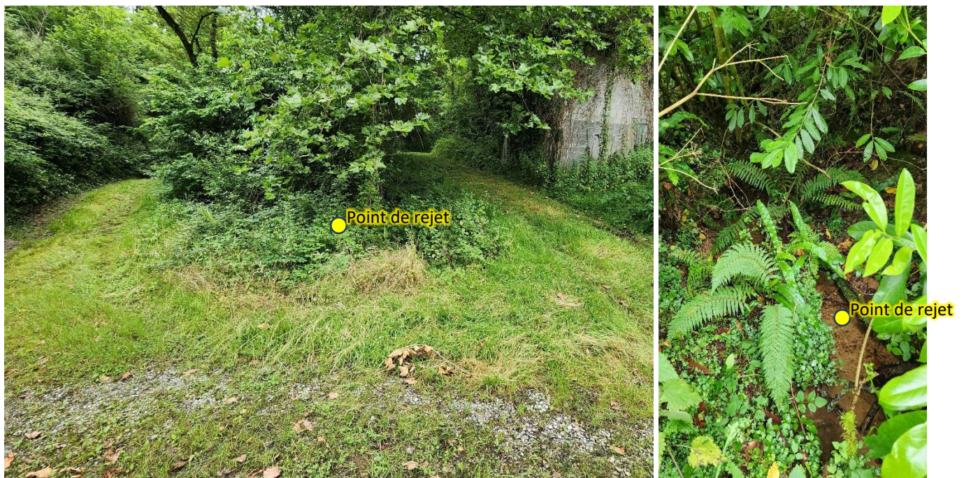
Figure 12 : Point de rejet du pompage sur IP2Bis
