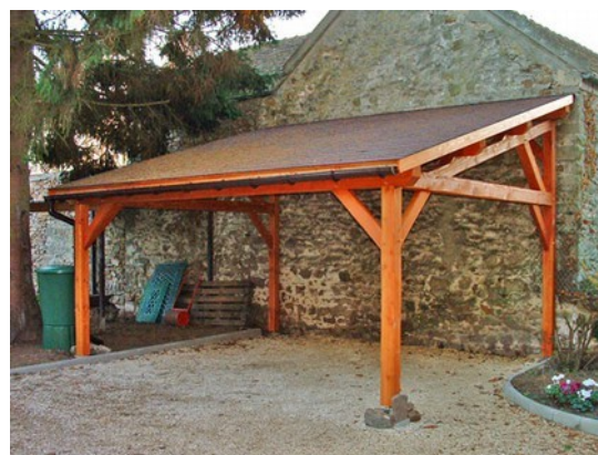
Abri de protection accolé à bâtiment (adjonction)
