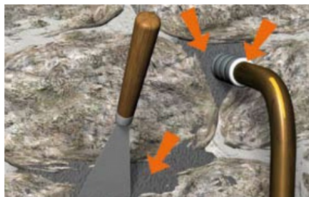
Situation après travaux de colmatage
