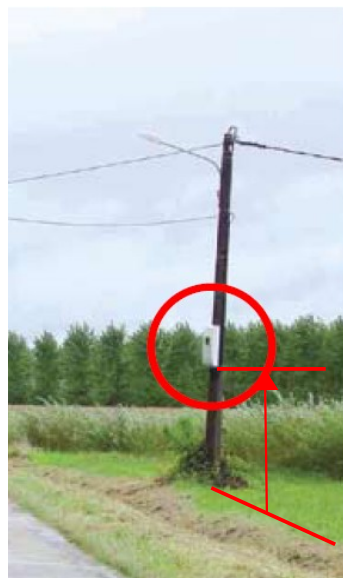
ETE du sud-ouest.
