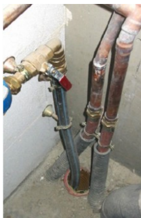
Exemple d'entrées de réseaux à calfeutrer
