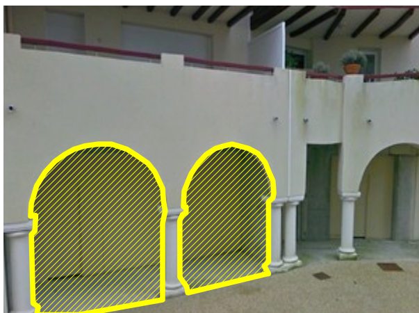
Obturation d'une travée de galerie
